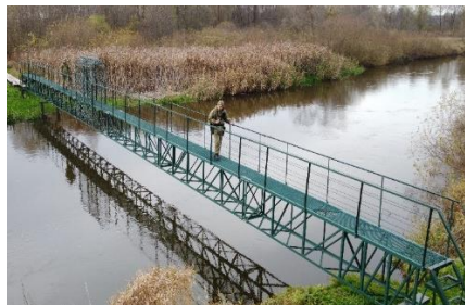
Сборно-разборный металлический мостовой пролет СРГММ-1
